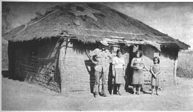
Fig. 11.18 — Cafua típica construída de pau-a-pique e barro, coberta de sapé, com a família de moradores. Cafua infestada por T. infestans .
